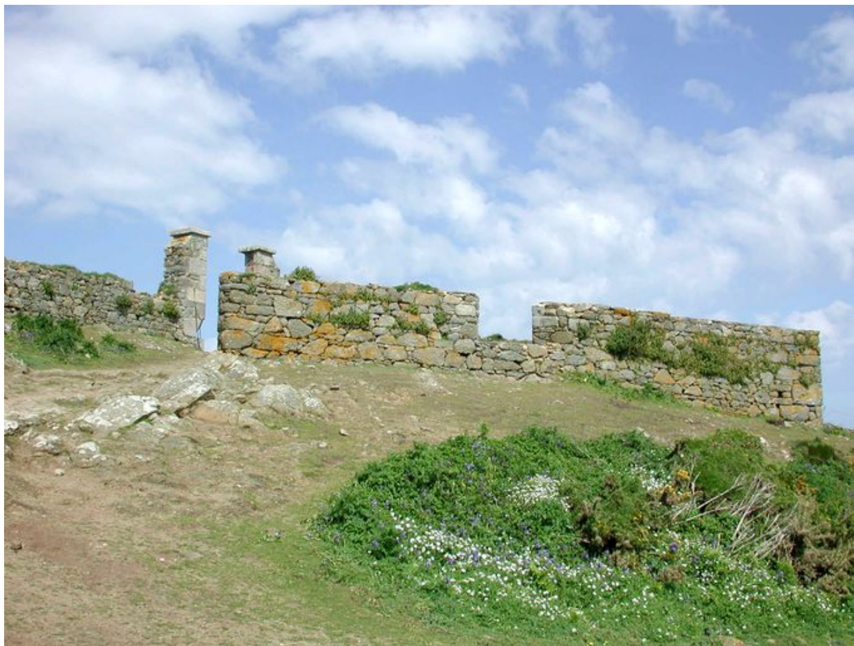
Vue de l'entrée précédée d'un redan doté de deux embrasures (état en 2002)
