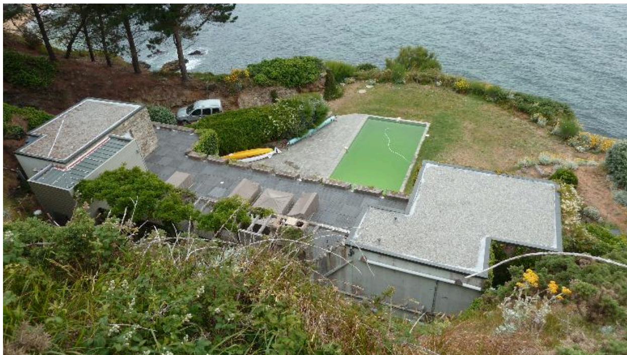
Locmaria, batterie de la pointe d'Arzic, la plate-forme de la batterie basse et le corps de garde crénelé.
