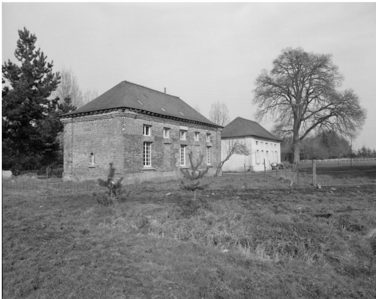
Pavillons d'entrée côté sud
