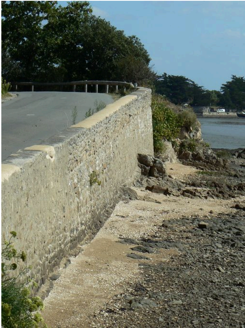
Digue-route du Passage Saint-Armel
