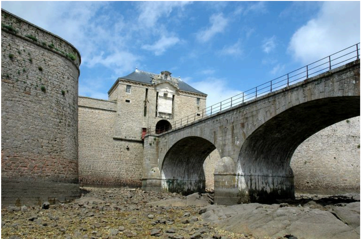
Vue de la citadelle de Port-Louis : piles du grand pont en granite permettant de franchir le canal, pont-levis et porte monumentale du corps de place
