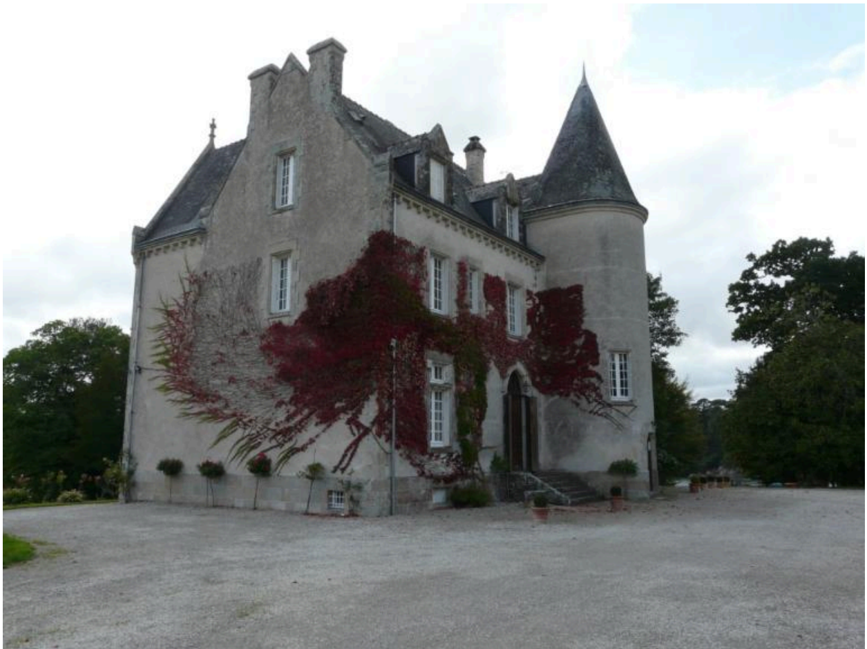
Façade nord et façade est
