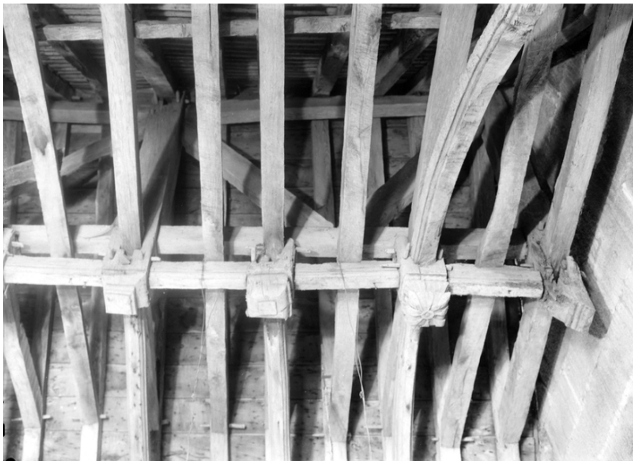
Combles nord du corps central, détail : abouts de poinçons, partie sud
