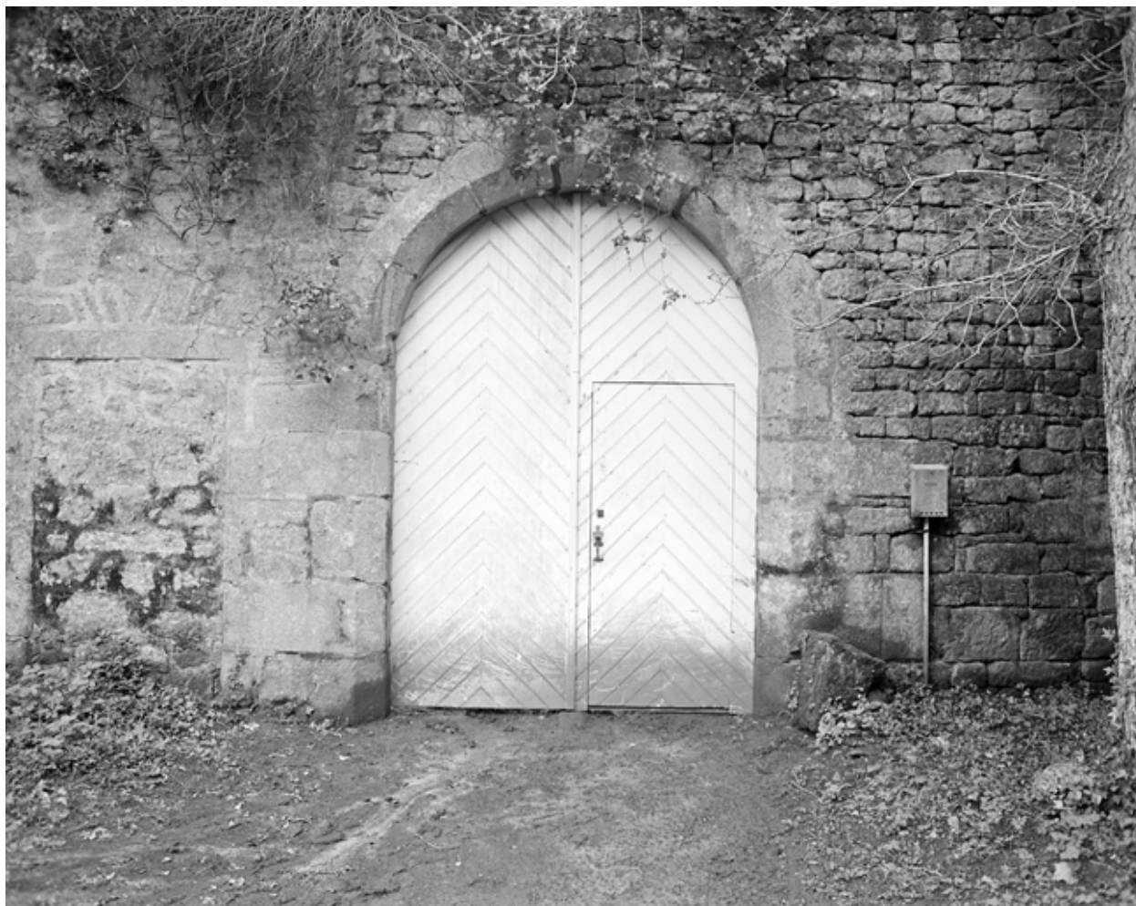
Portail d'entrée, vue nord. (1983)
