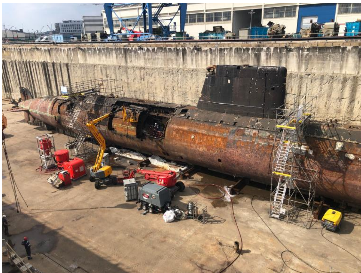
La coque de l'Agosta dans la forme de radoub n° 1 du port de Brest : chantier de déconstruction, 22 septembre 2021
