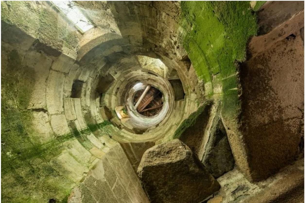
Elevation ouest, détail d'un escalier en vis
