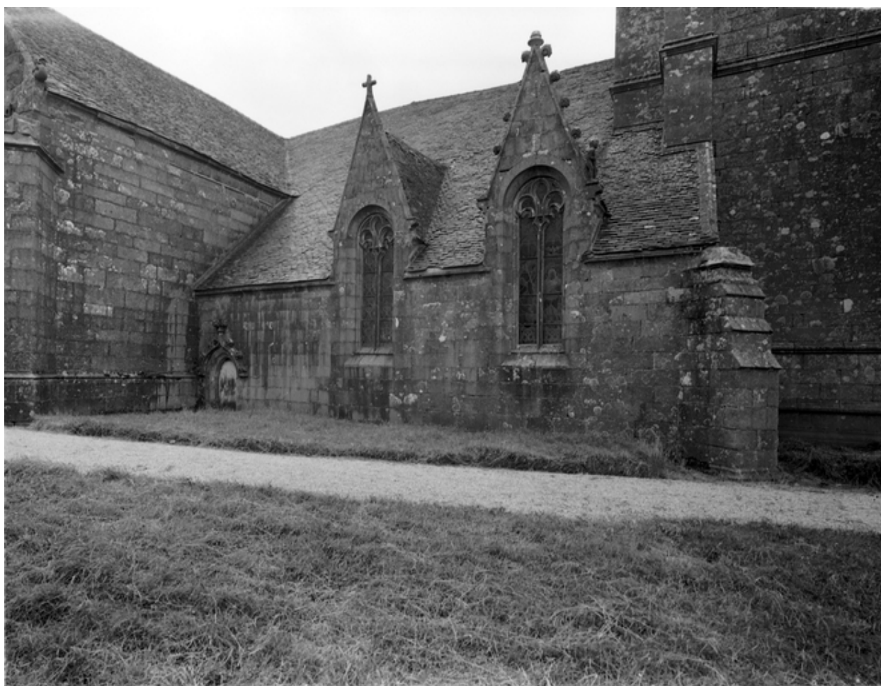
Vue extérieure du mur du bas-côté nord
