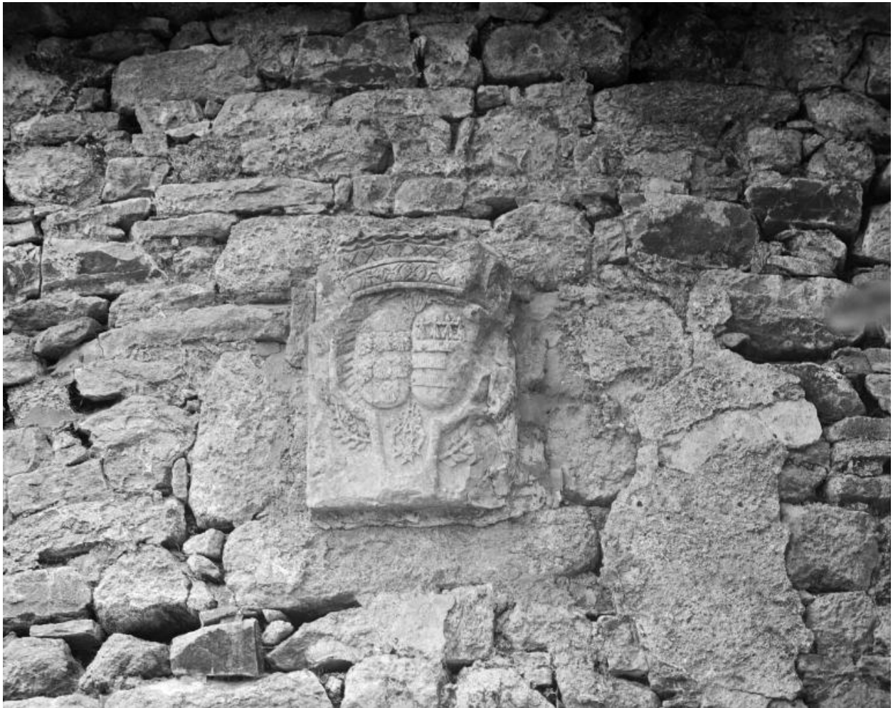
Château, colombier, détail des armoiries.
