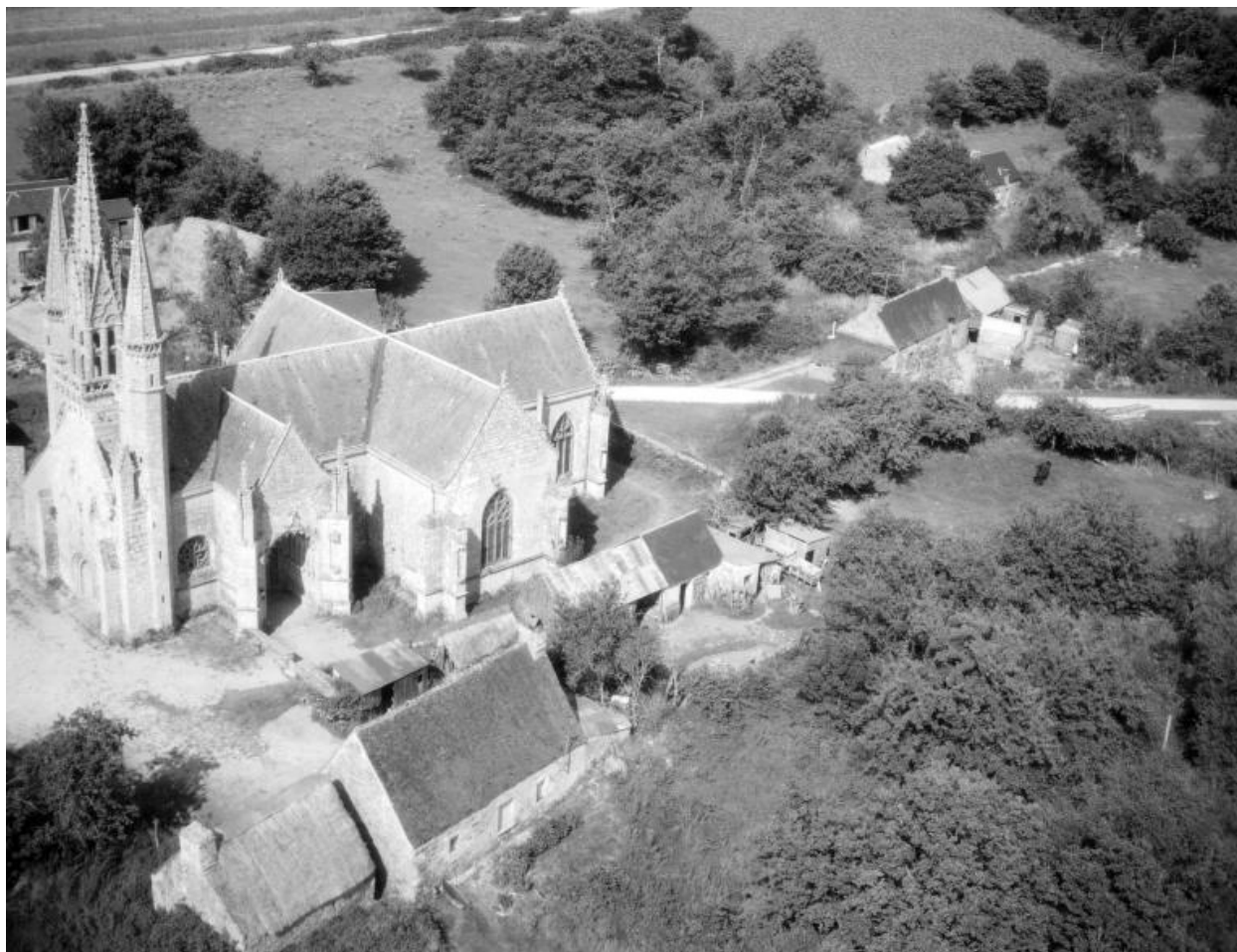
Vue aérienne sud-ouest.
