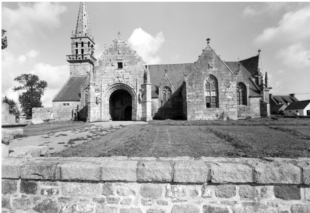
Vue générale de la façade sud
