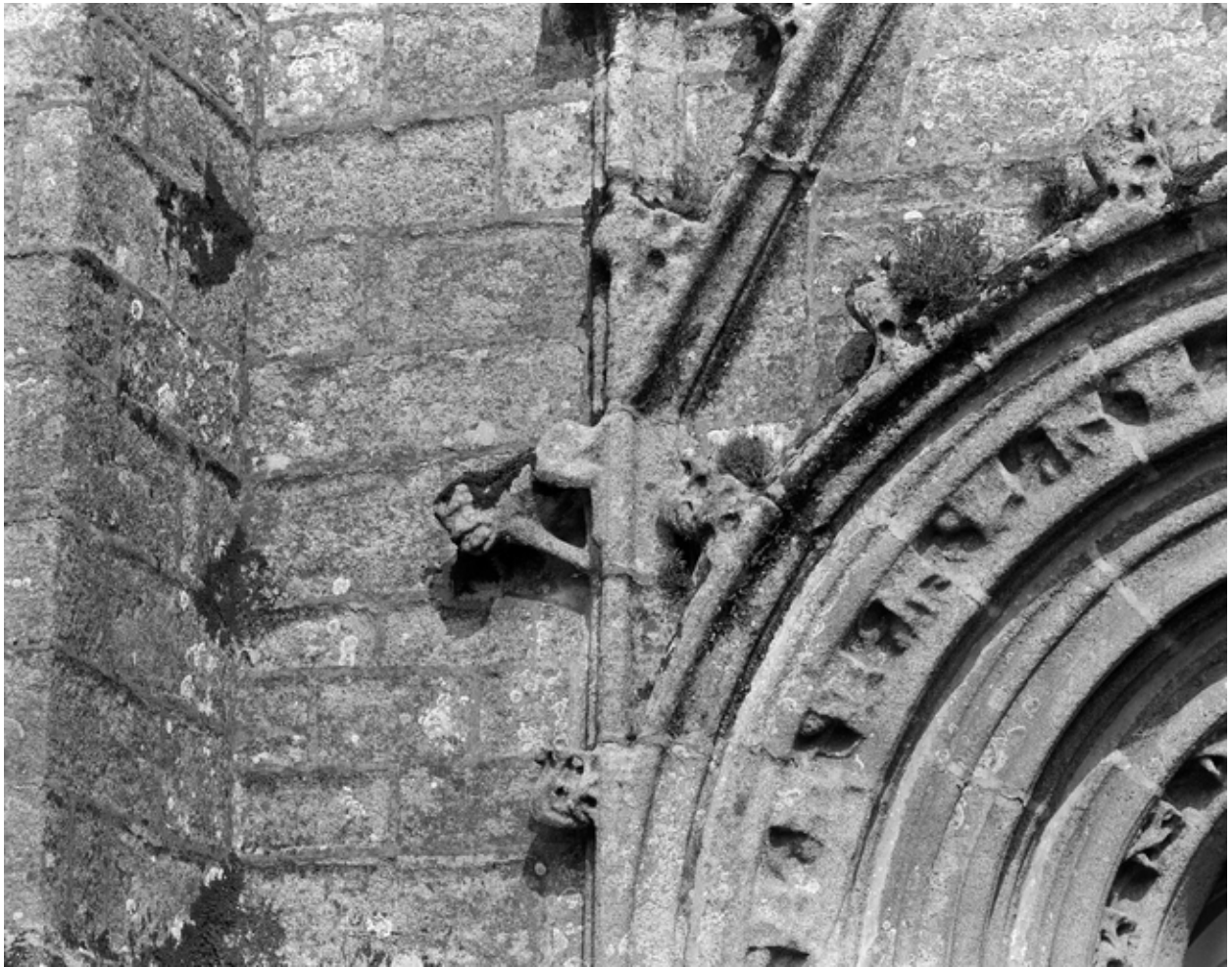
Chapelle du Pénity, façade ouest, détail gauche
