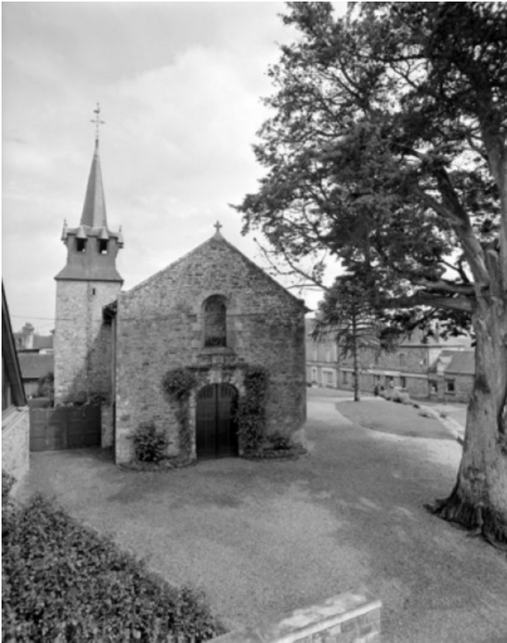
Elévation ouest : vue générale
