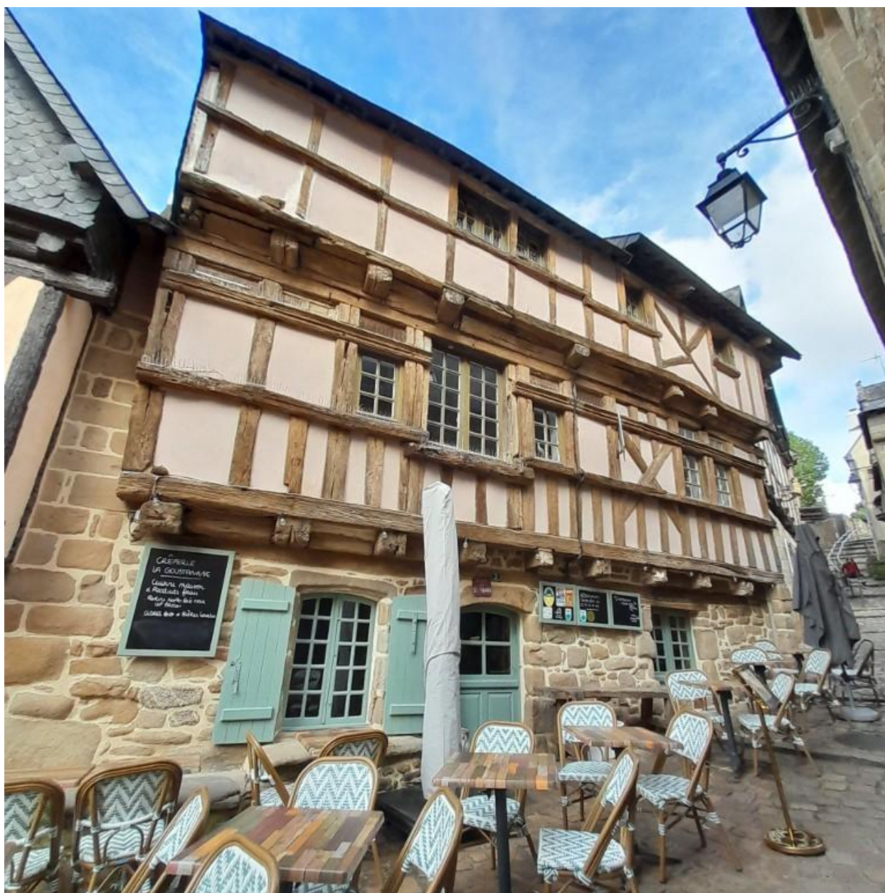
Façade en pan de bois avec encorbellement sur solives.
