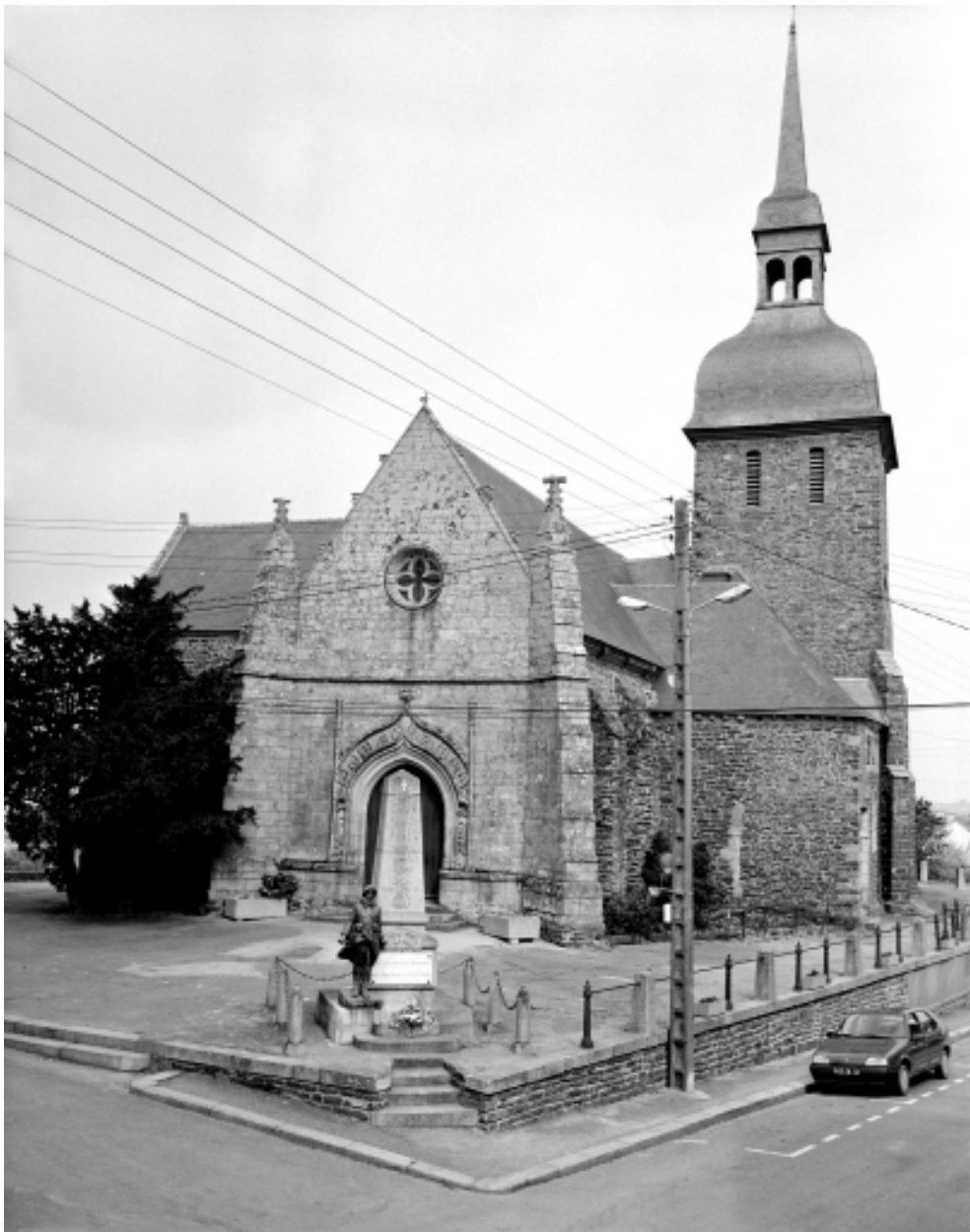
Vue générale ouest
