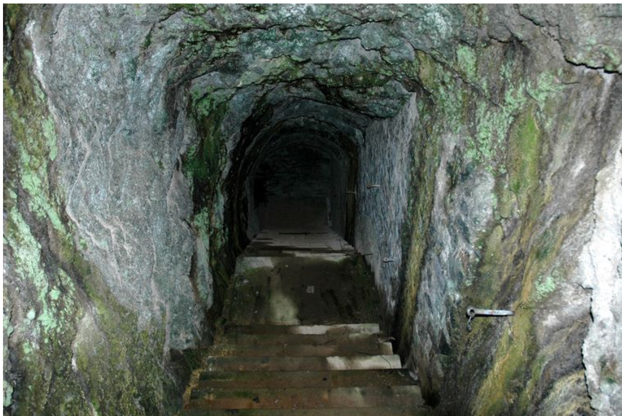
Vue de l'escalier - galerie d'accès (état en 2005)
