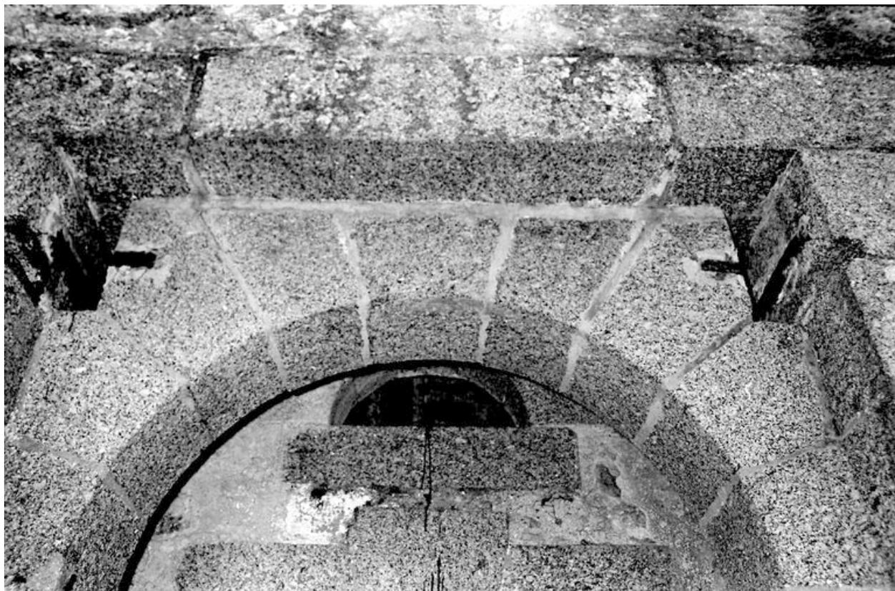
Vue du corps de garde crénelé n° 3 du bourg de Roscanvel en 1969 : porte d'entrée, détail de la feuillure d'encastrement du pont-levis et des passages des chaînes de manoeuvre
