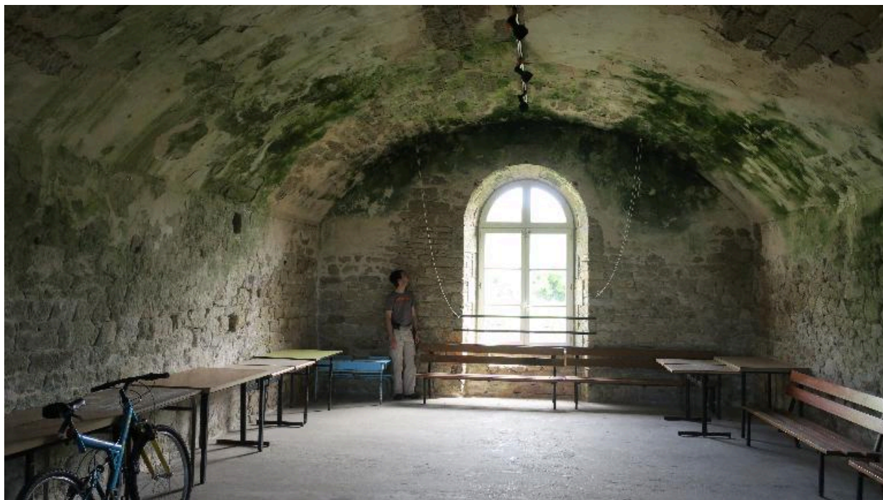
Hoedic, fort central, caserne à l'épreuve, casemate du deuxième étage.
