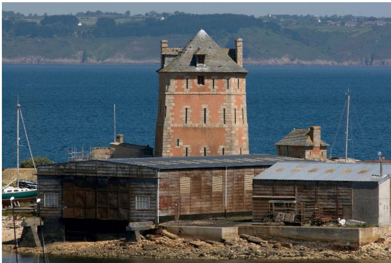
Camaret-sur-Mer : vue de la tour Vauban
