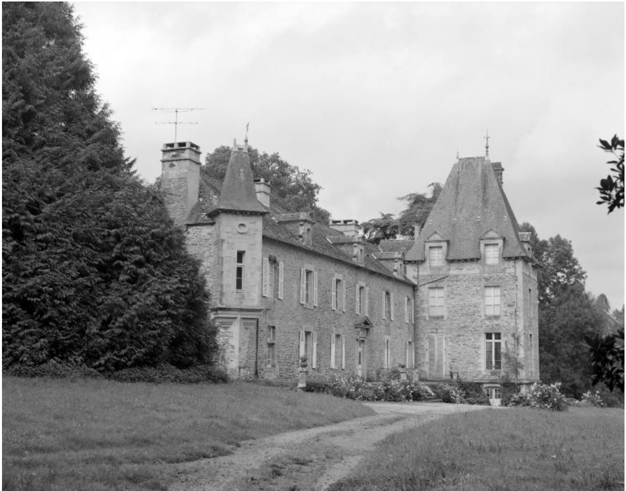
Château : élévation ouest (état en 1984)
