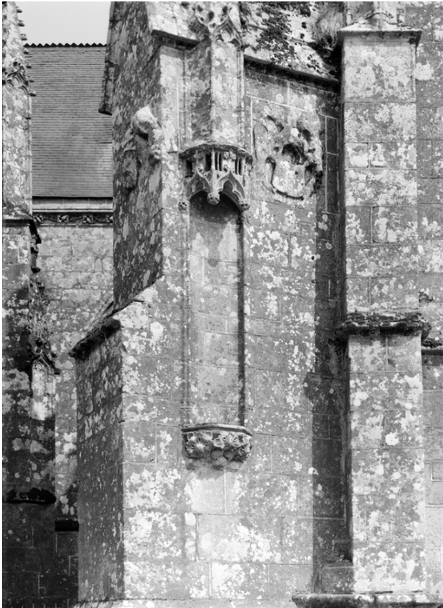
Niche du croisillon sud.
