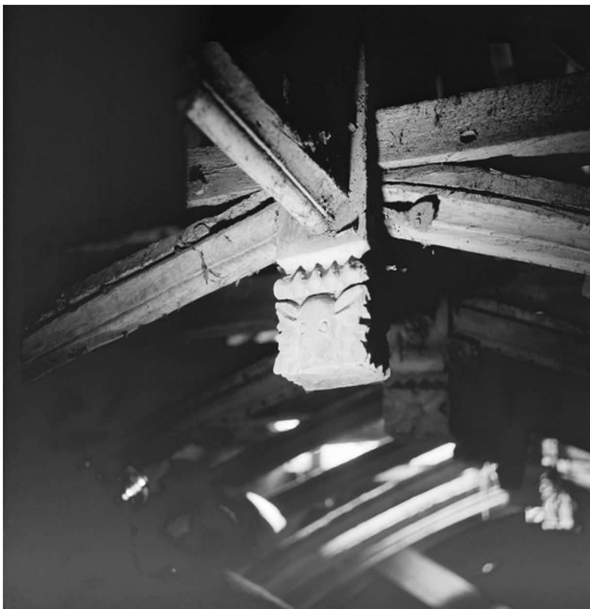
Charpente, détail de la clé 9.
