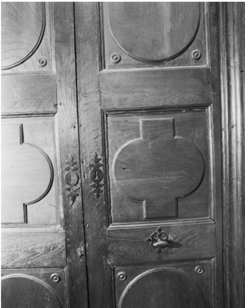
Etage, couloir, détail d'un vantail de porte
