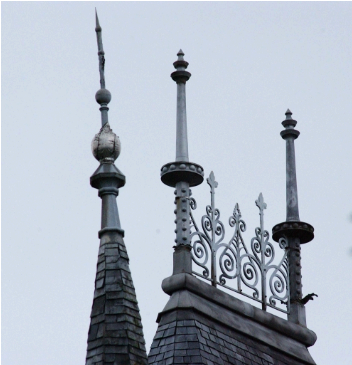
Faîtage de toiture
