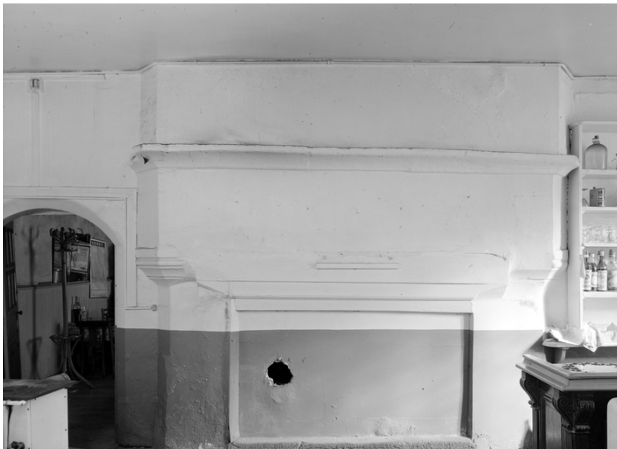
Cheminée contre le mur sud-est de la pièce 1.
