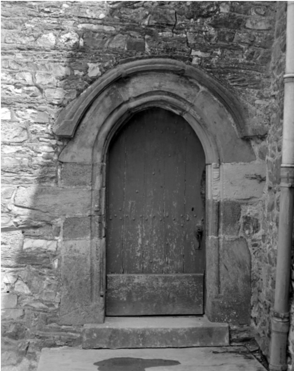
Elévation nord, porte du transept : vue générale
