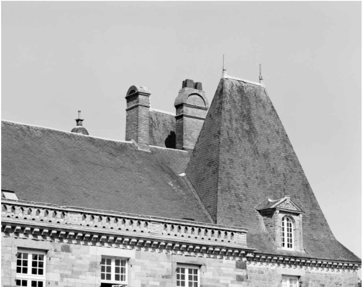
Toit en pavillon sud-est, vue générale.
