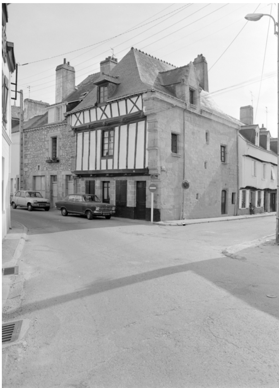
Maison d'angle en pan de bois et maçonnerie (état en 1978).
