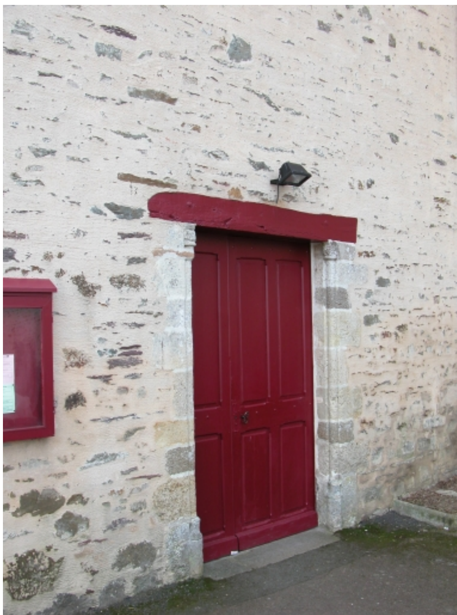
Porte du bras de transept nord
