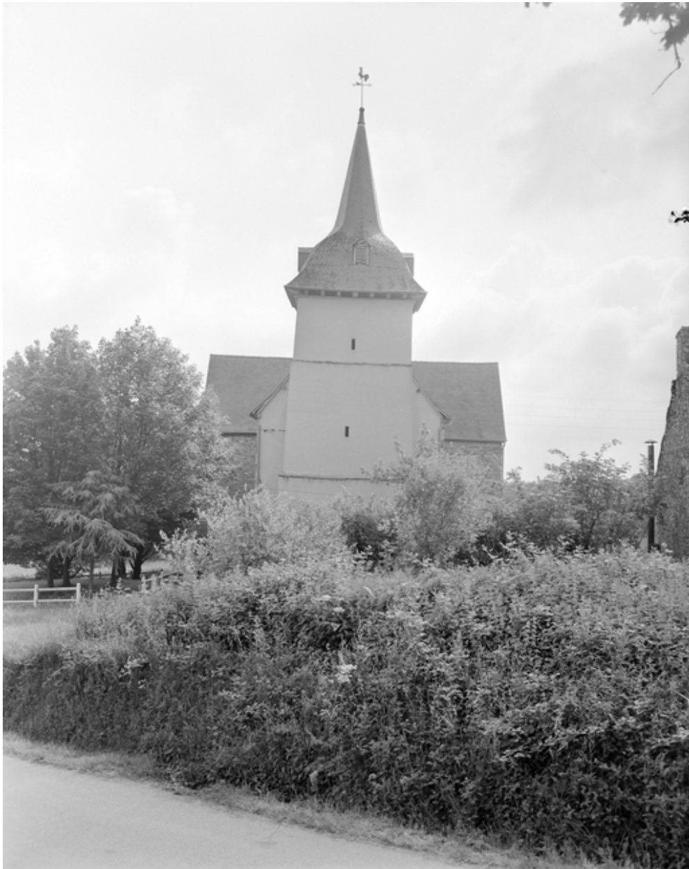
La tour porche : vue générale ouest
