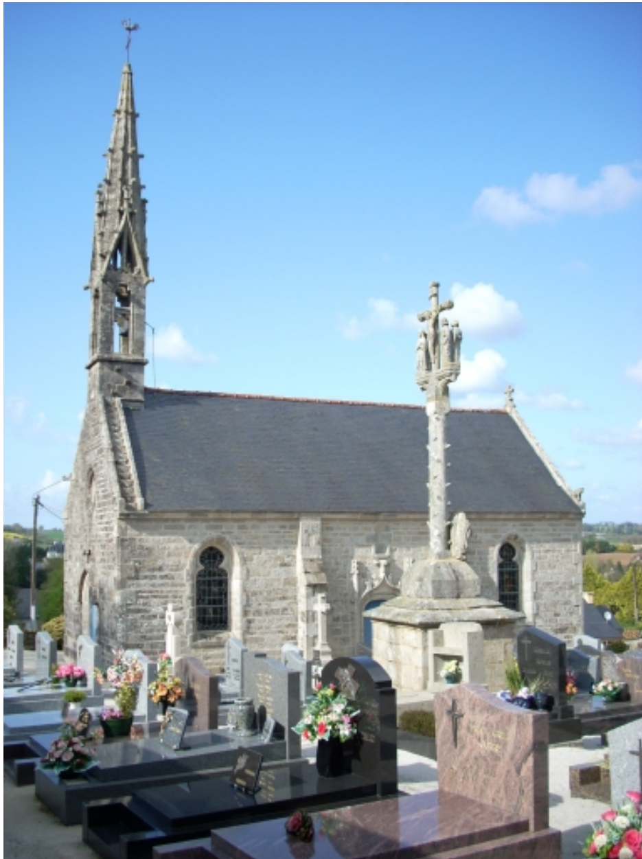
Chapelle Saint-Guénolé : vue générale sud
