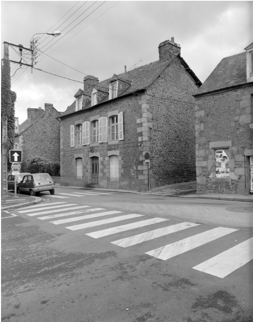
Elévation sud, vue générale.
