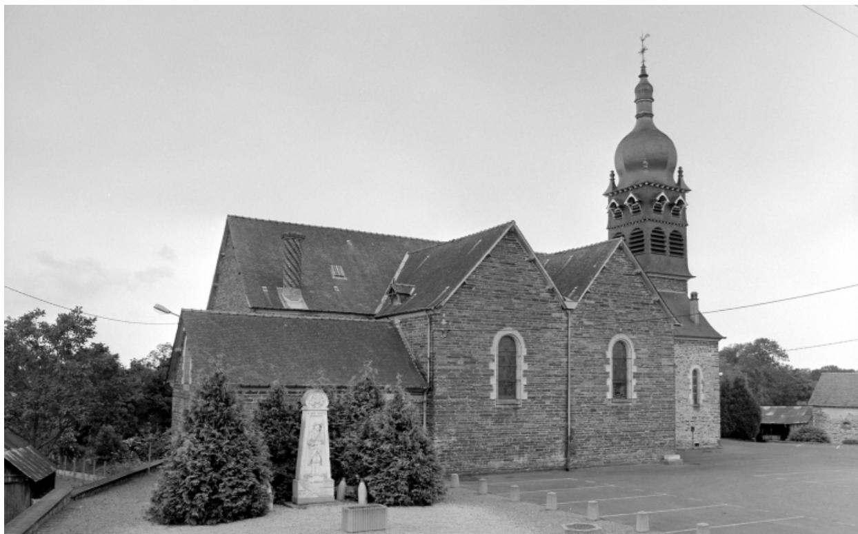
Elévation Nord : vue générale
