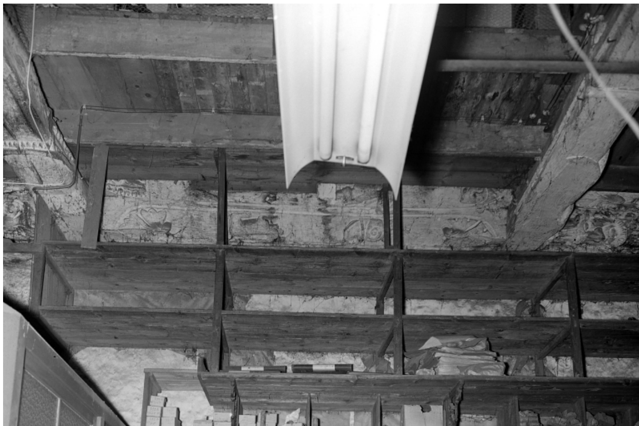
Première travée nord, sablière.
