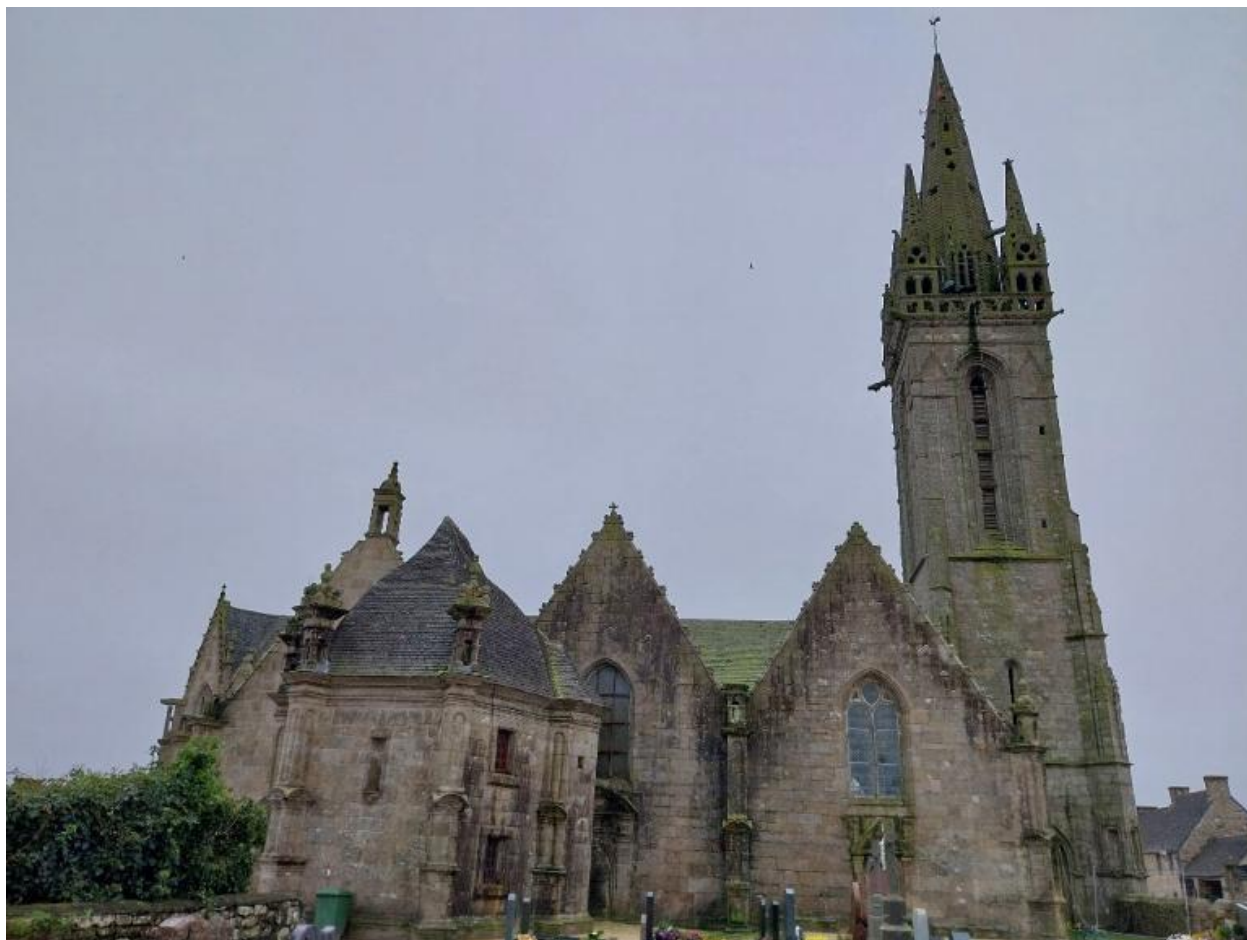
Vue de la façade nord avec la sacristie et le clocher
