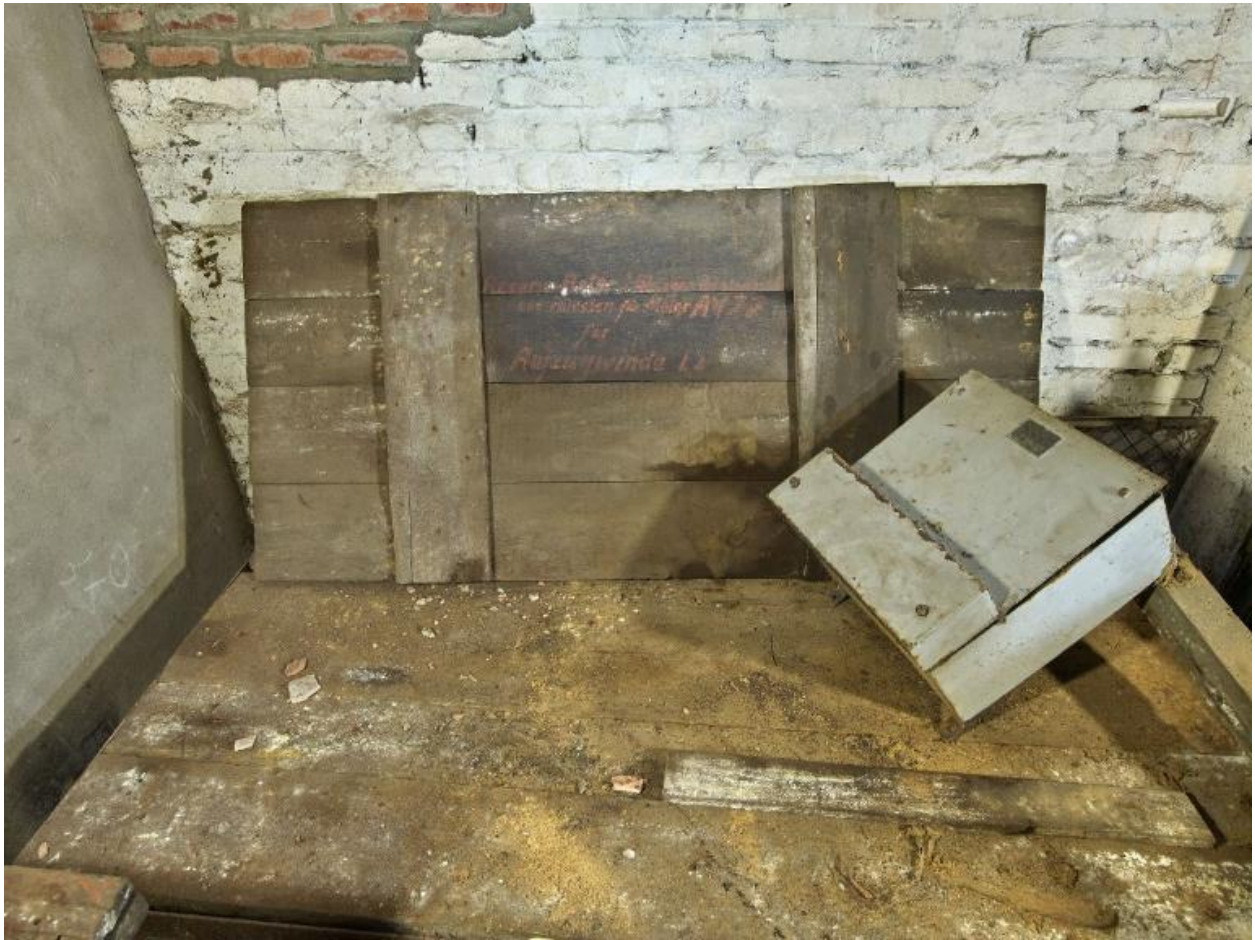
Vue du sous-sol de la centrale électrique : atelier de réparation et magasin de stockage, vestiges de caisse en bois de transport avec marquage en allemand
