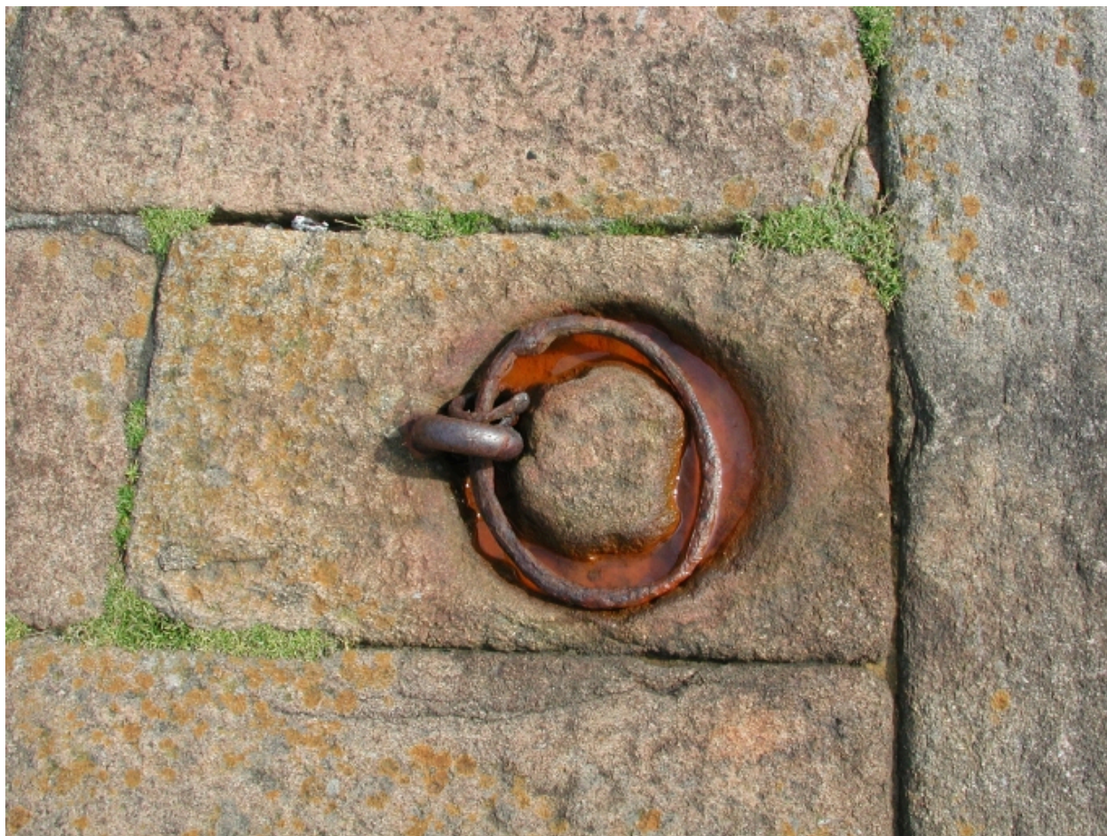
Vue en détail d'un anneau d'amarrage scellé au quai
