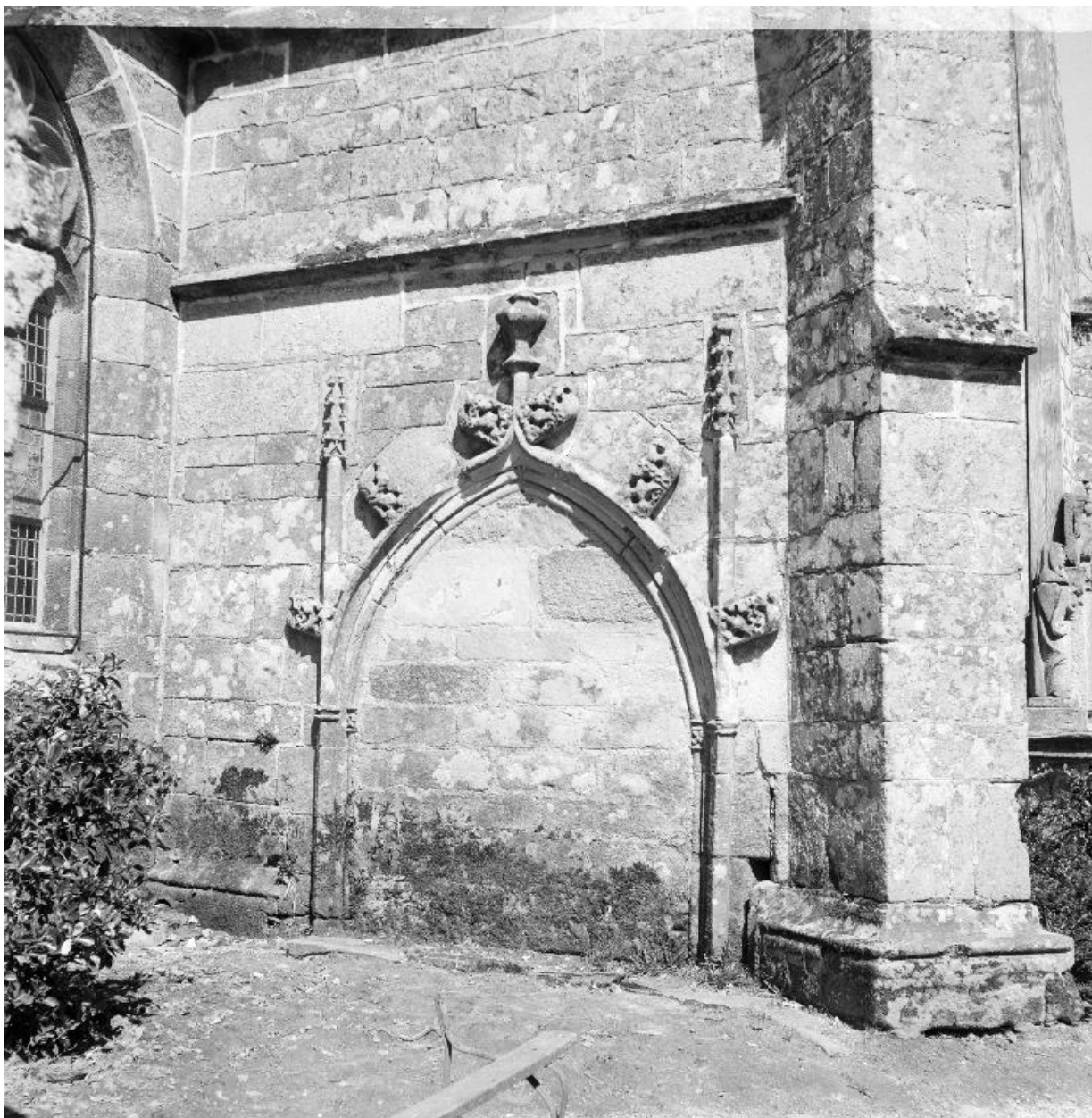
Porte bouchée sur la face ouest du bras sud du transept
