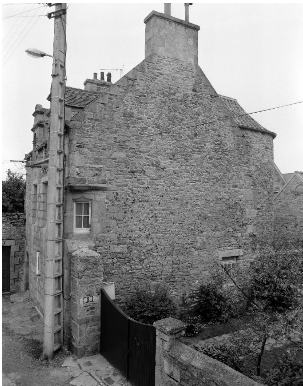
12 rue Yan d'Argent, élévation est, vue générale
