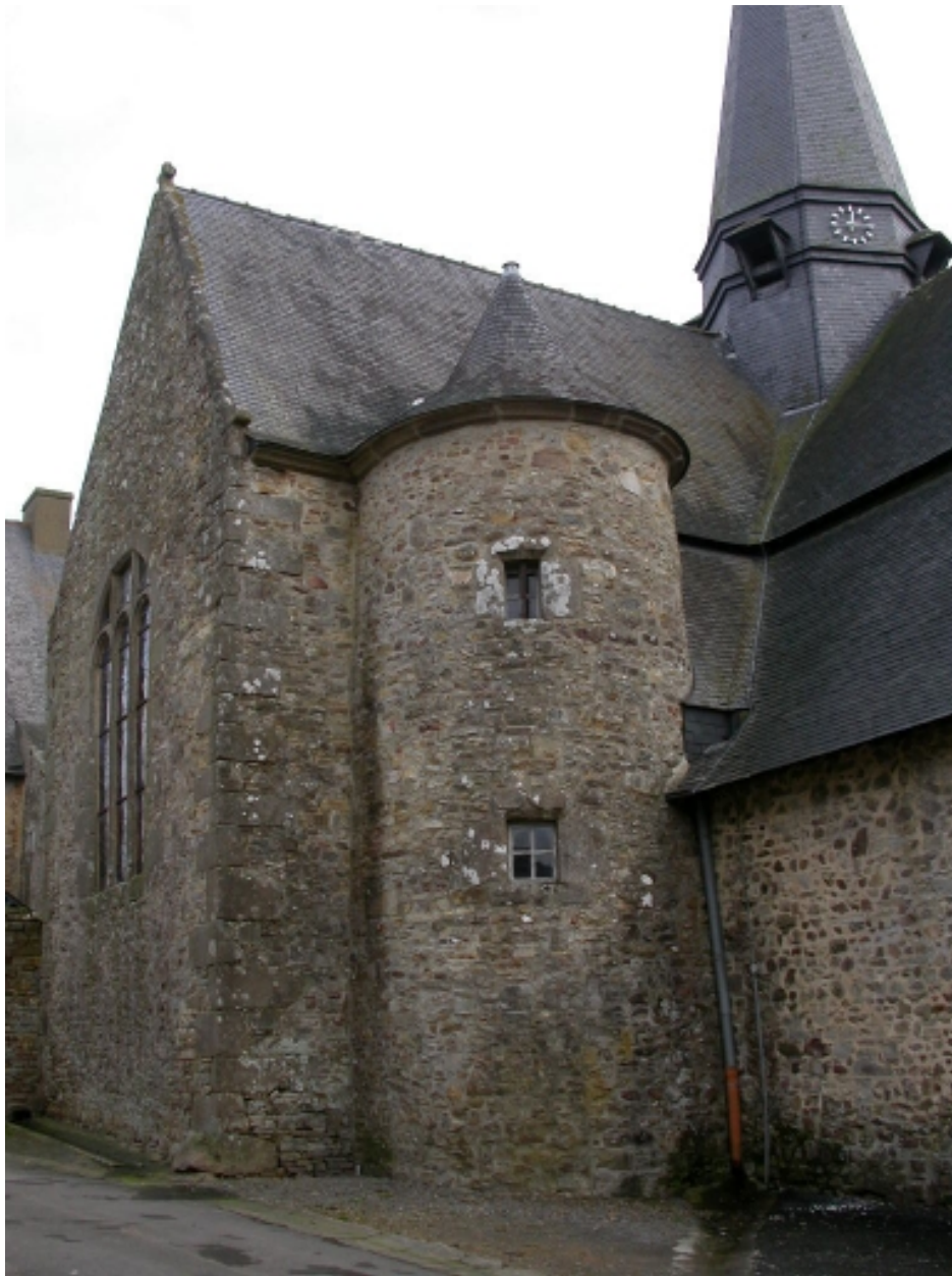
Tourelle d'escalier située sur la façade nord
