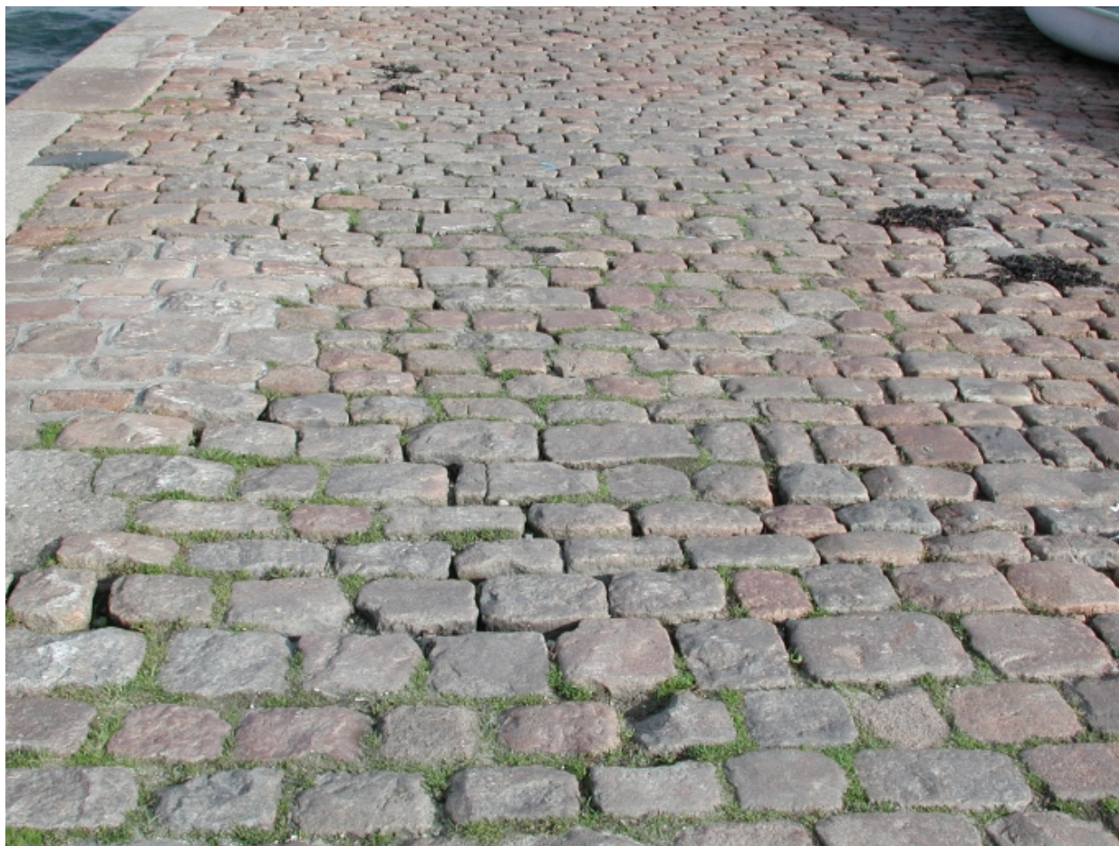
Vue de détail du revêtement en pavés de la cale Bitousse
