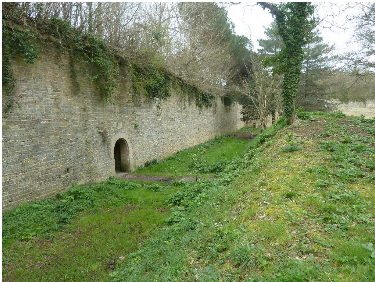
Le Palais, enceinte urbaine, courtine 19-20.
