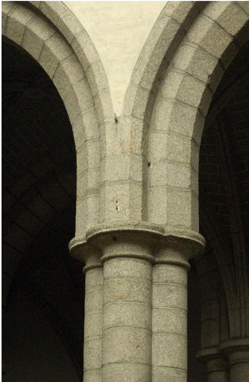
Vue d'une pile du chœur
