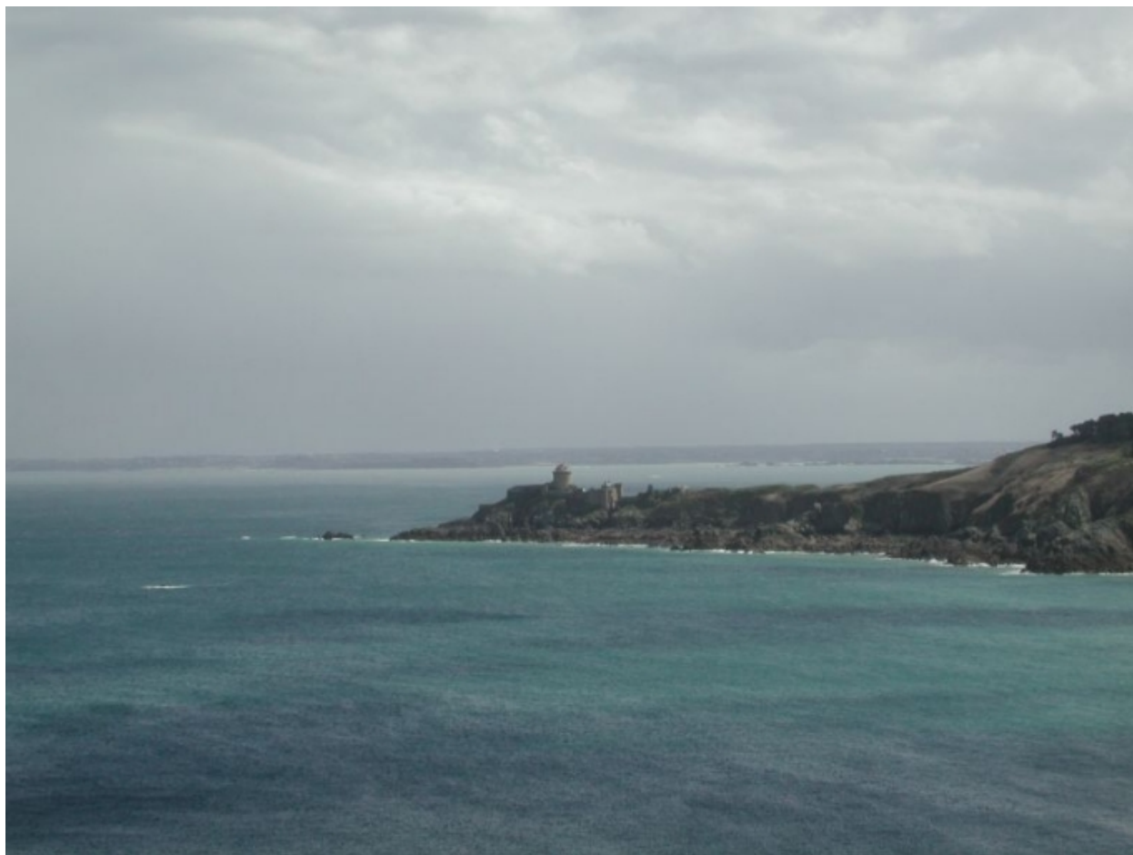
Vue générale de situation
