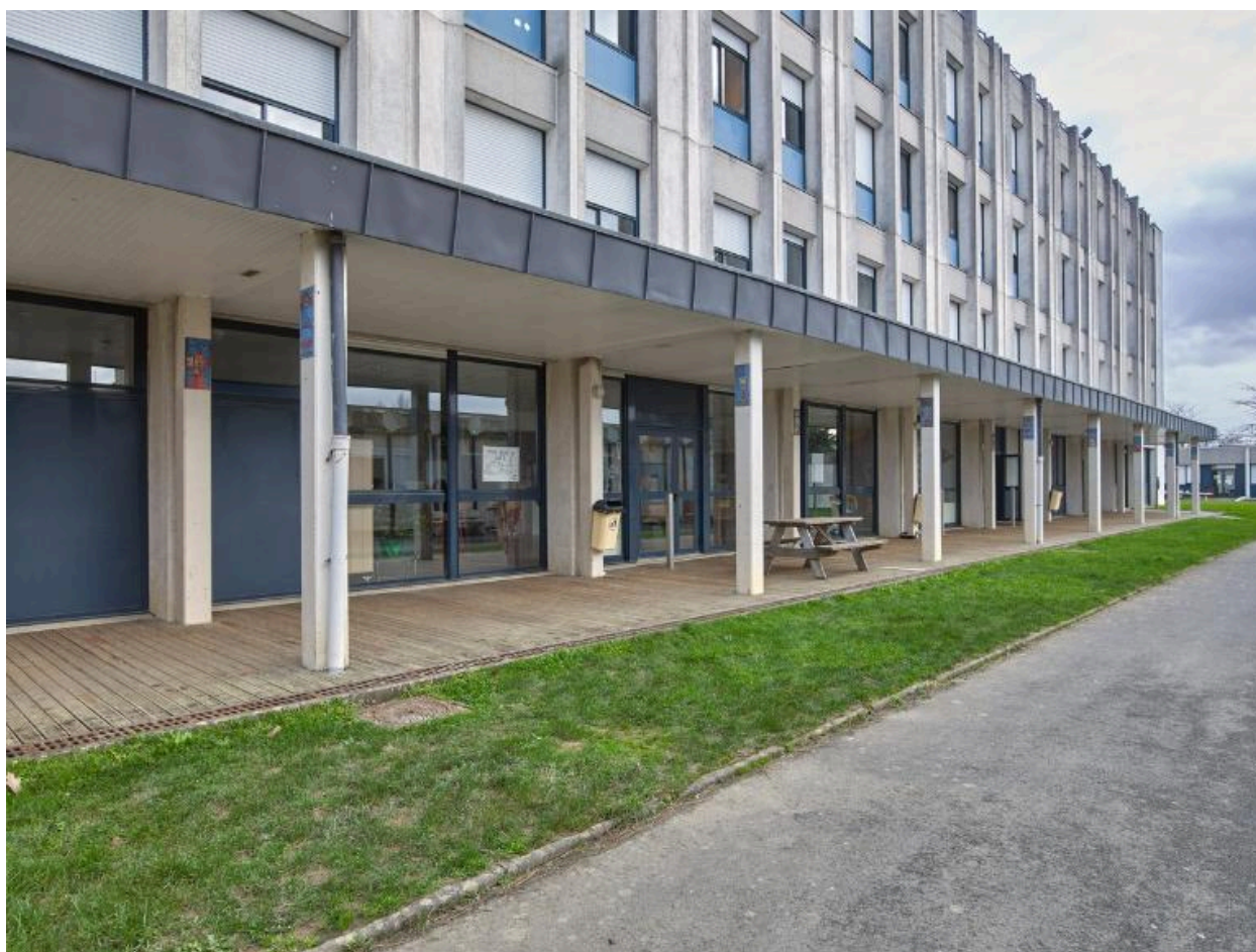
Façade ouest de l'internat, à la trame porteuse très affirmée (Roger Besnard, architecte, 1973), précédée d'une galerie ajoutée ultérieurement.
