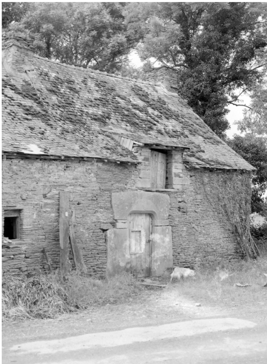
Maison : élévation nord (état en 1983)
