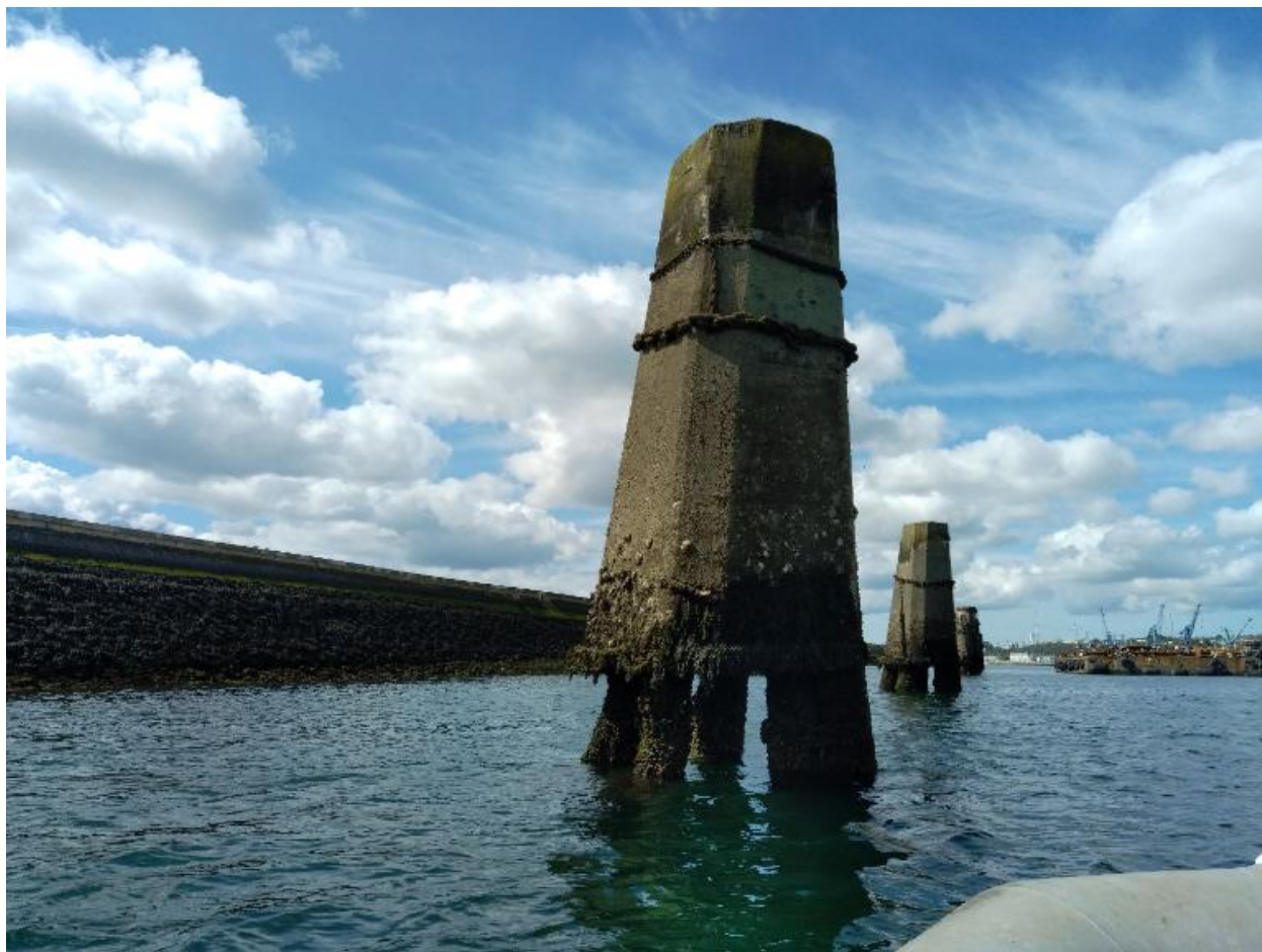
Digue sud et ducs d'Albe en béton armé
